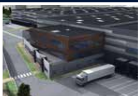
LIDL Saint-Quentin-Fallavier Location : 46 000 m 2
