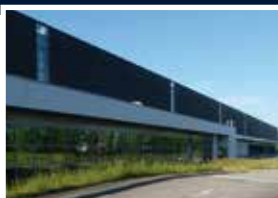
AUCHAN INTERNATIONAL Saint-Quentin-Fallavier Location : 43 000 m 2
